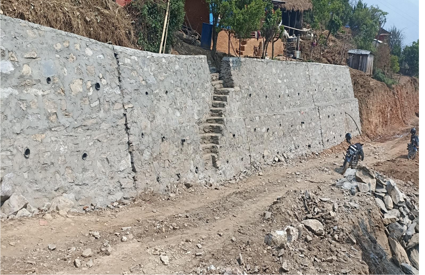
राक्से सालफेद द्वार दुंगा बिसौना चौक भएकोट सडक वाल (GABION)/(Wall) का.गा.पा-२
