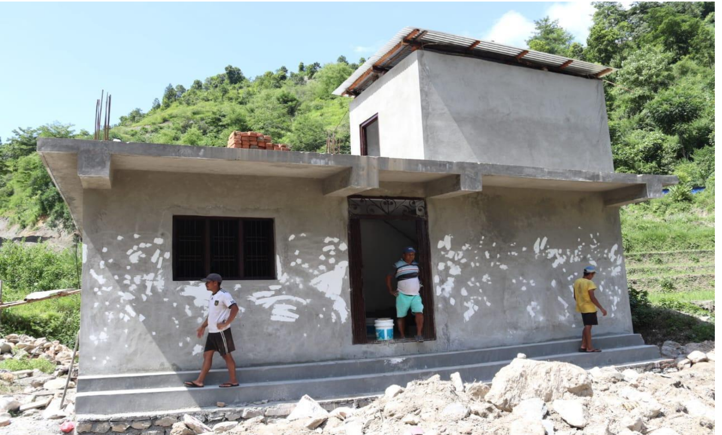
निर्माणाधिन वडा कार्यालय भवन पुर्तीघाट वडा नं. ४
