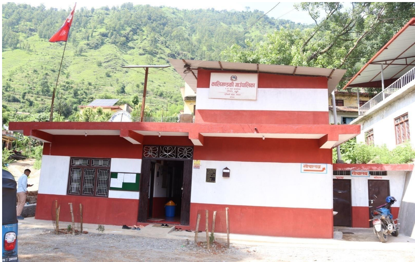
वडा नं. १ को नव निर्मित वडा कार्याल भवन
