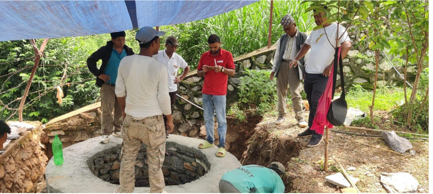
निर्माणाधिन फोक्सिङ्ग स्वास्थ्य चौकी प्लासेन्टा पिट वडा नं. ५
