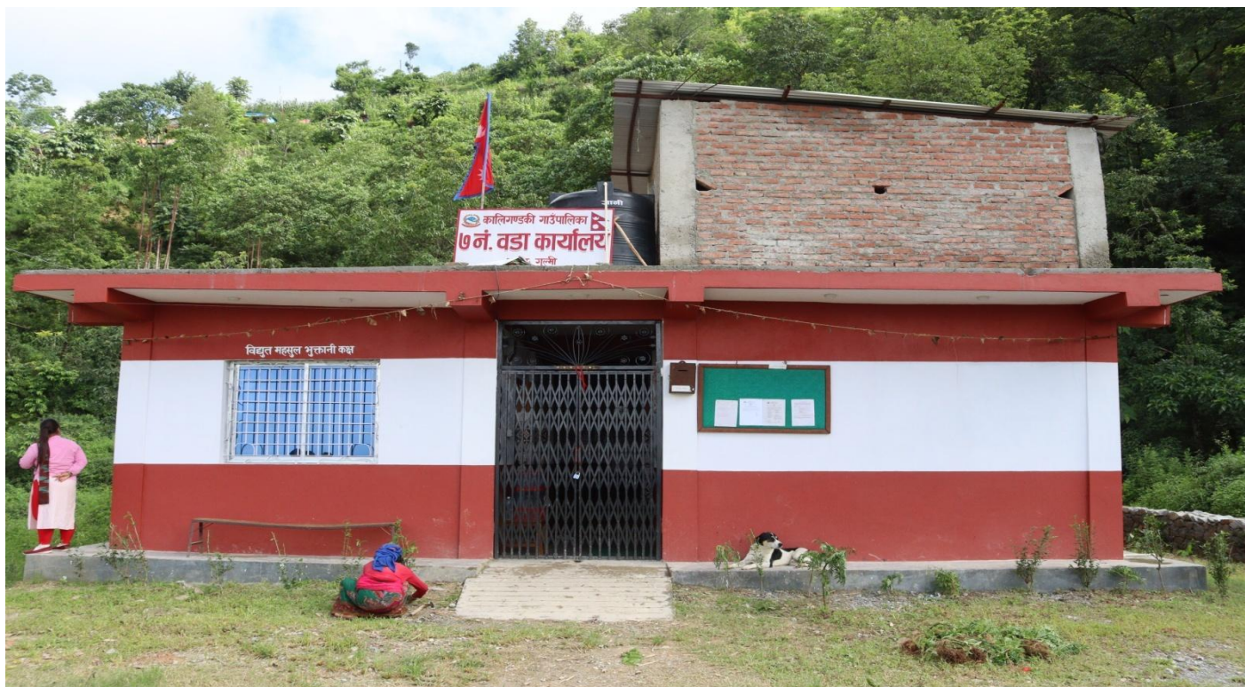
वडा नं. ७ को नव निर्मित वडा कार्याल भवन
