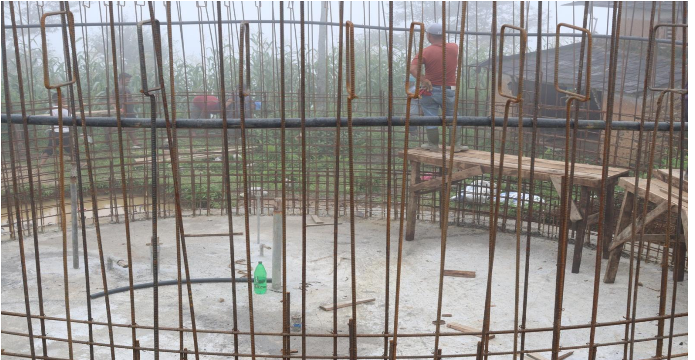
निर्माणाधिन धुवाँखोला खानेपानी टंकी वडा नं.
