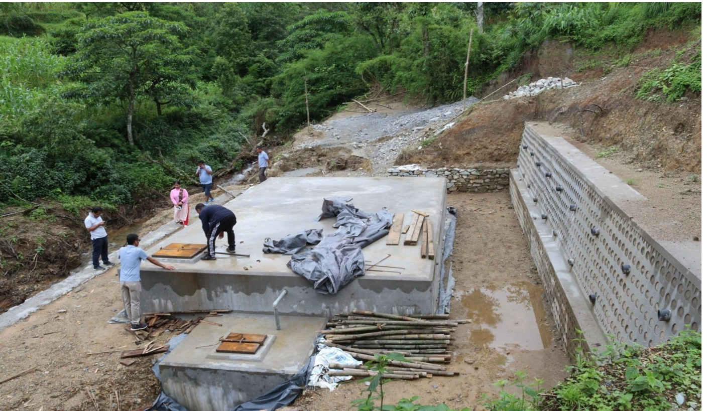
निर्माणाधिन धुवाँखोला खानेपानी योजना वडा नं. ७
