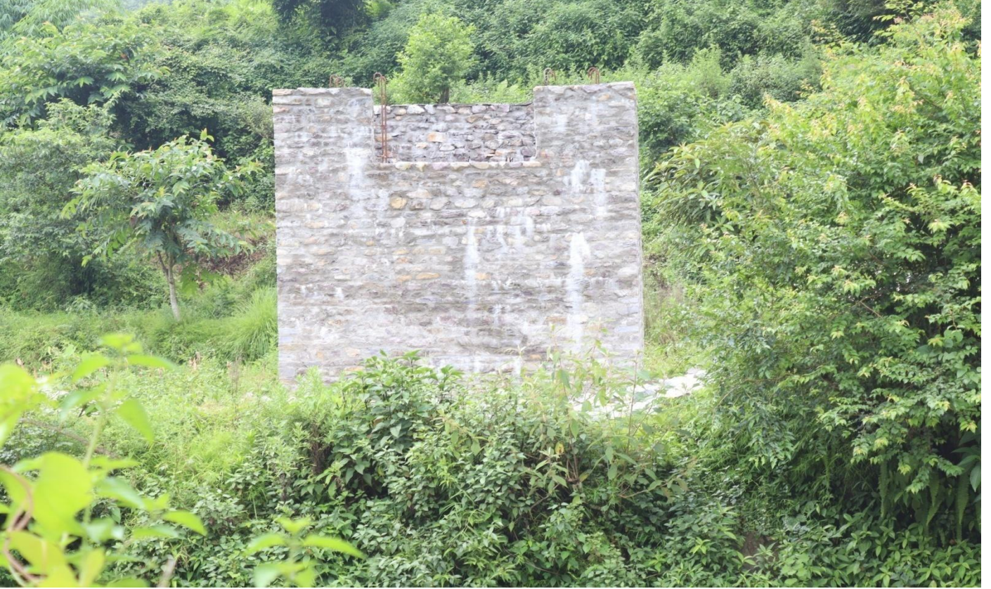
लम्करा चालिसे निर्माणाधिन झोलुङ्गे पुल वडा नं. ५
